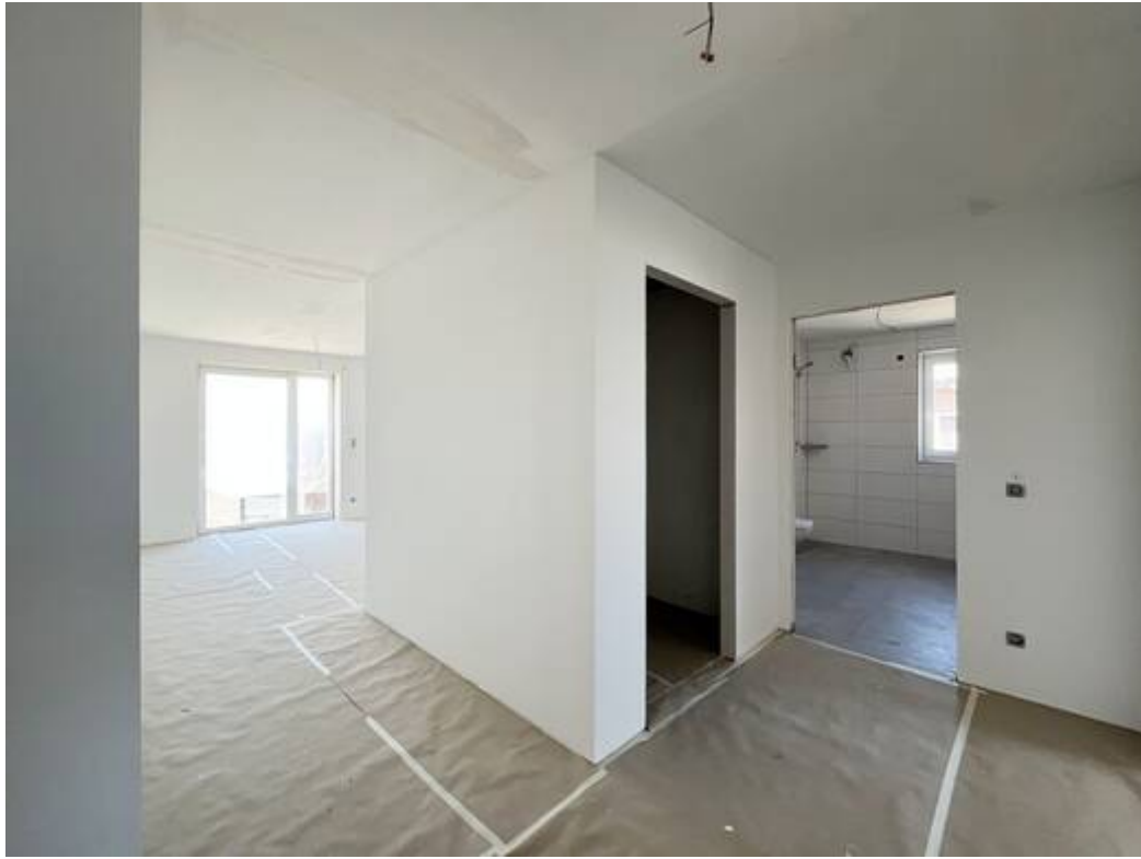
Wohnung im Bau
