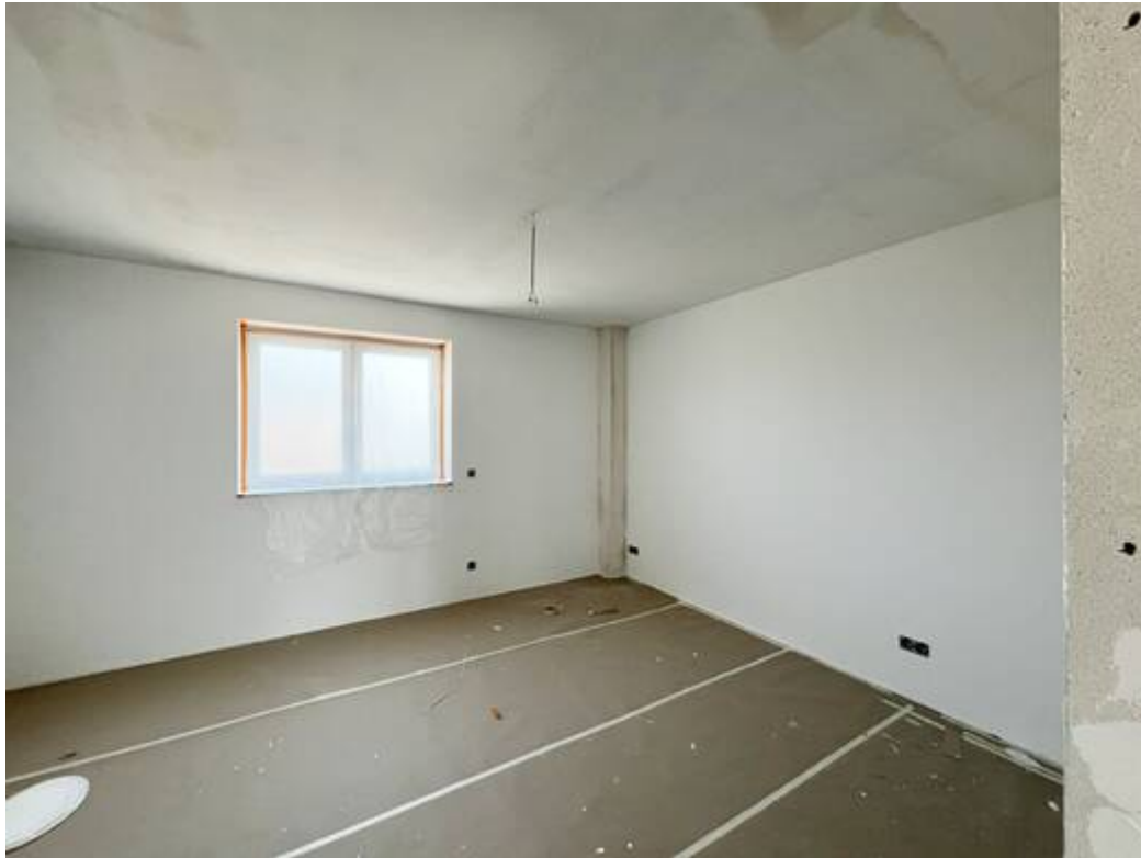
Wohnung im Bau
