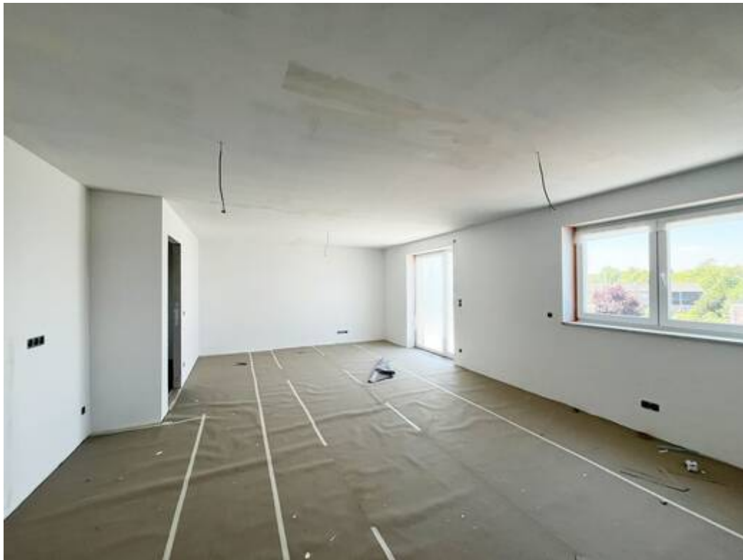
Wohnung im Bau
