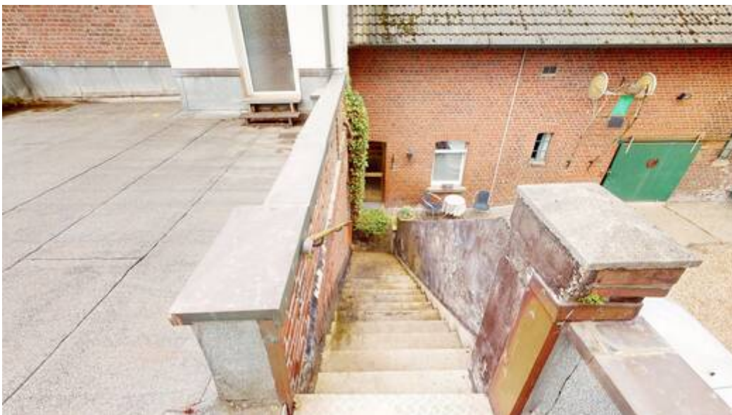
Zugang zur Dachterrasse
