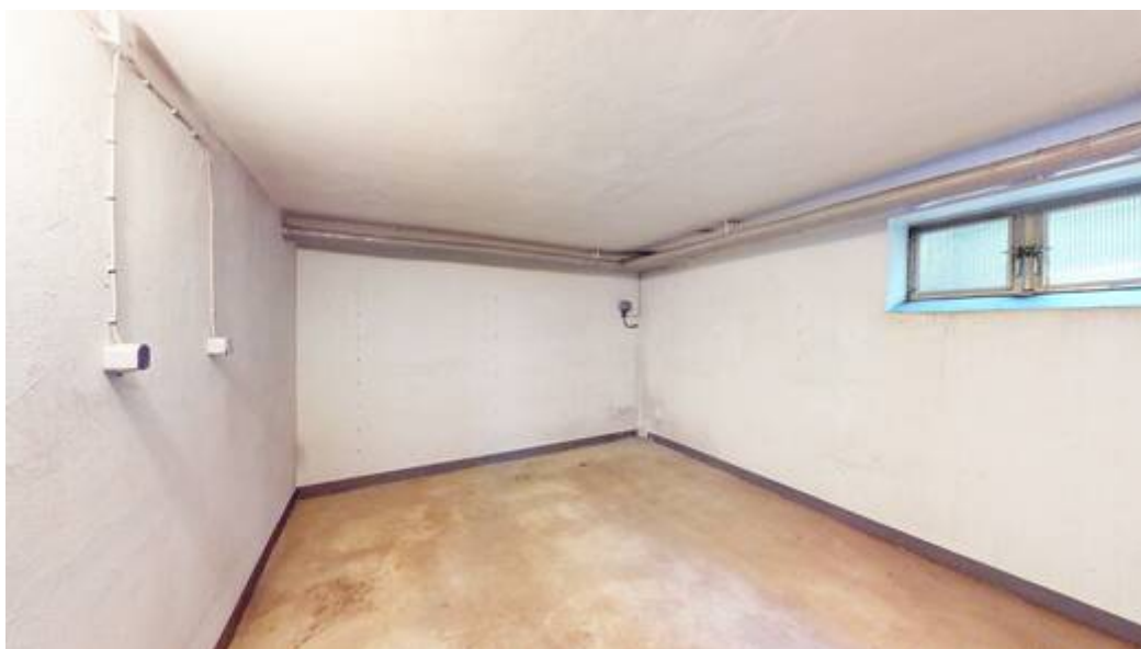
Kellerraum I von VI
