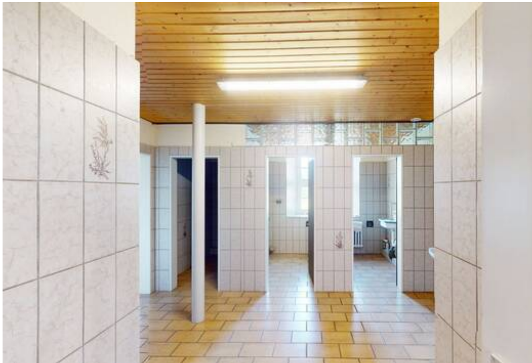
WC Anlage 1.0G
