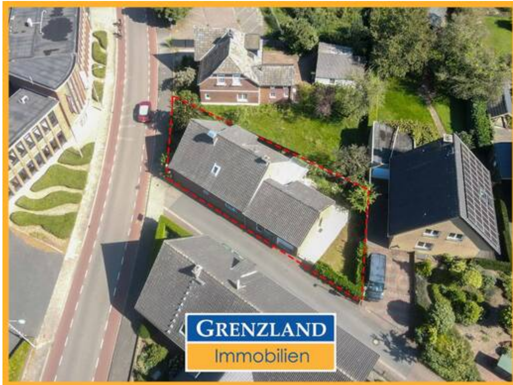
Handwerkerhaus in Suderwick
