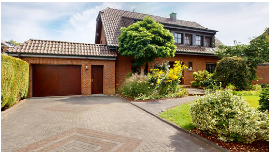
Wohnhaus mit Anliegergarage
