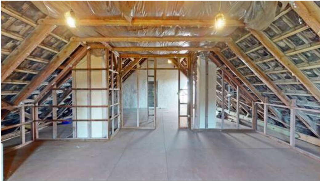
Ausbaureserve im Dachgeschoss
