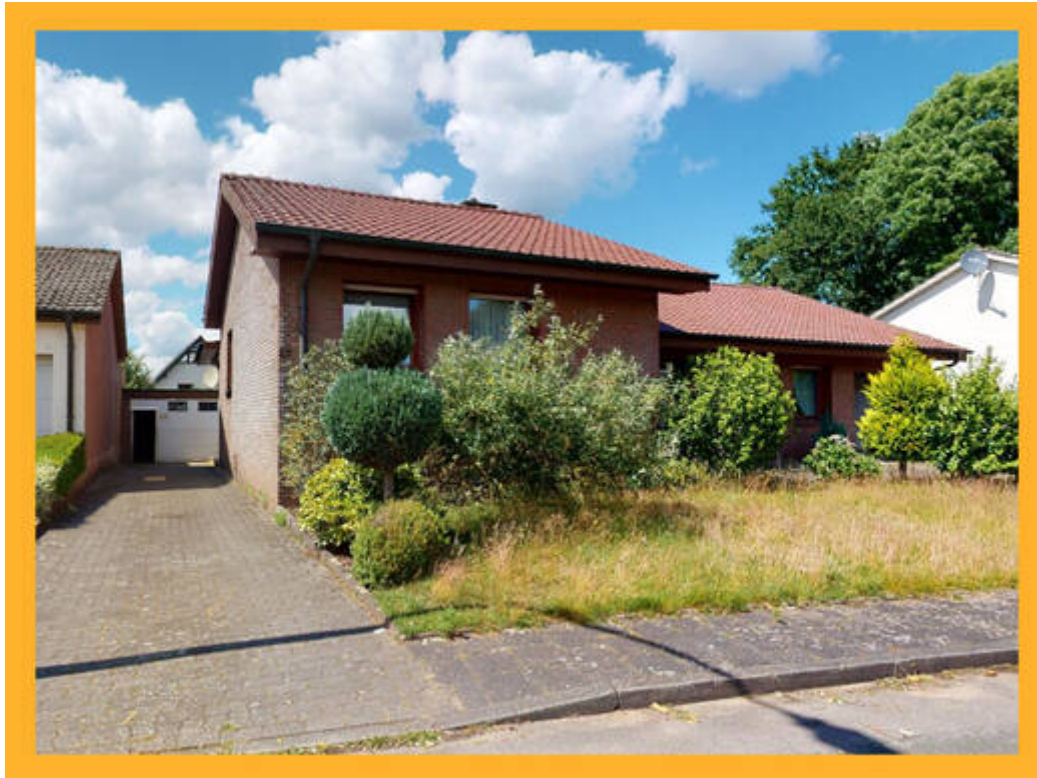
Freistehendes Familienhaus mit Sanierungsbedarf
