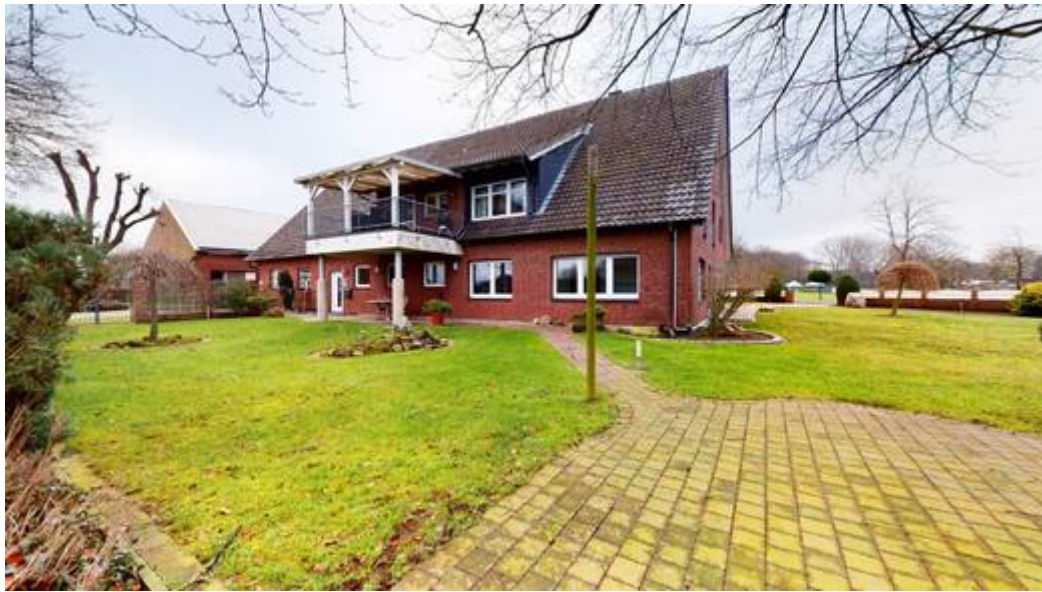
Haus- und Hofansicht
