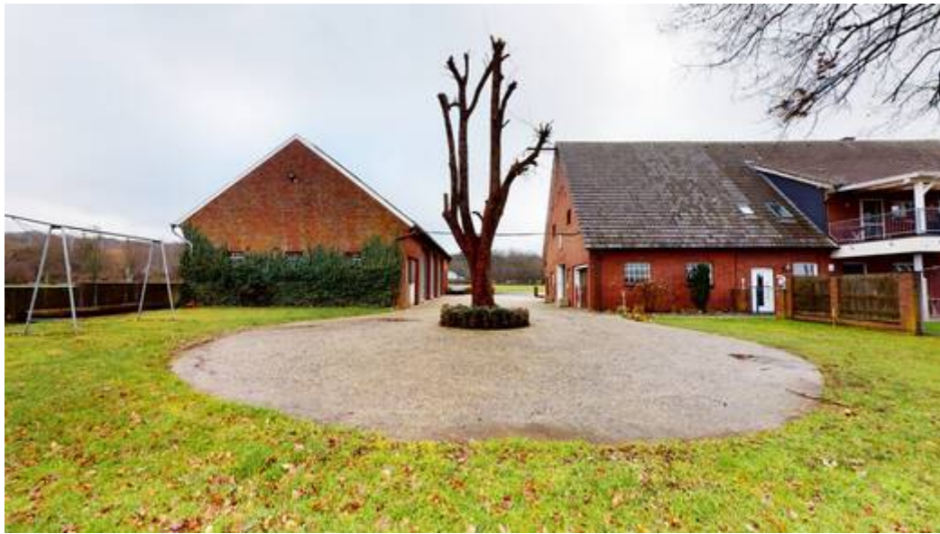
Haus- und Hofansicht
