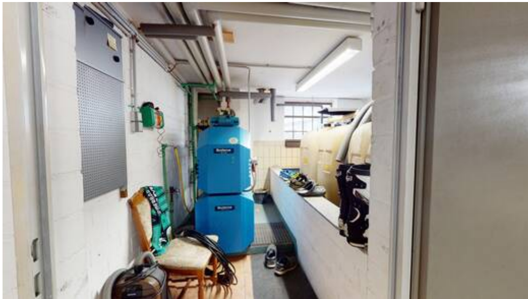
Heizungsraum - Ölheizung
