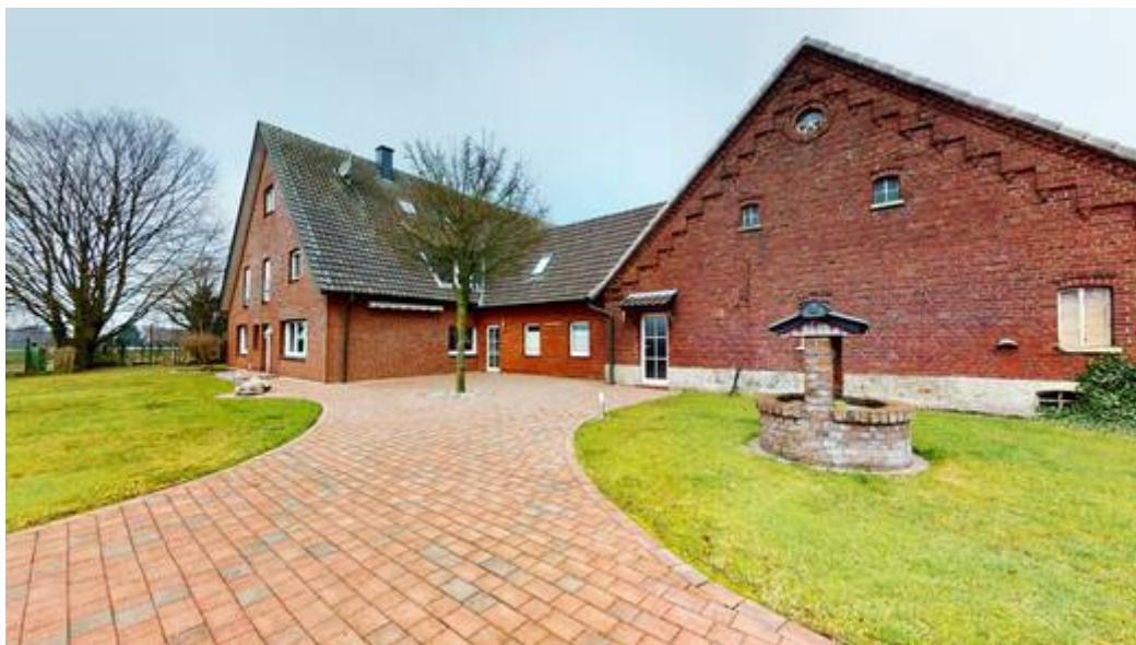
Haus- und Hofansicht
