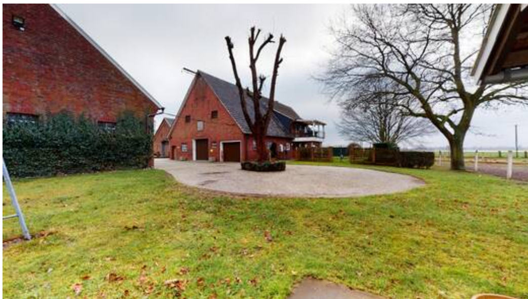
Haus- und Hofansicht
