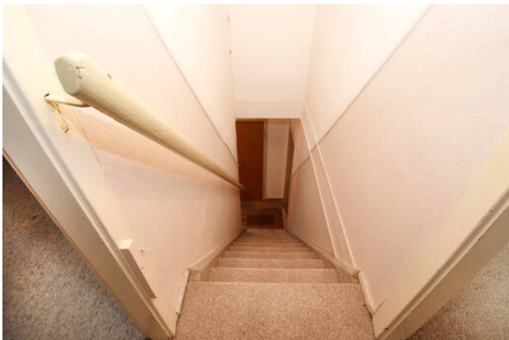
Treppe zum OG
