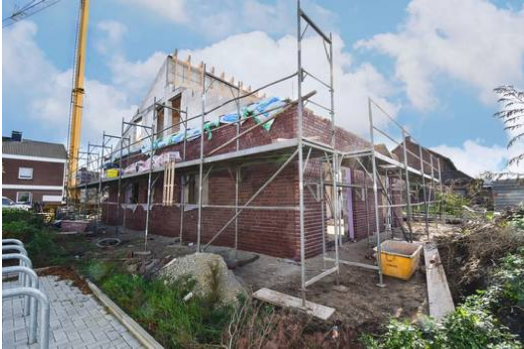
Freistehendes Luxushaus in Bauphase II
