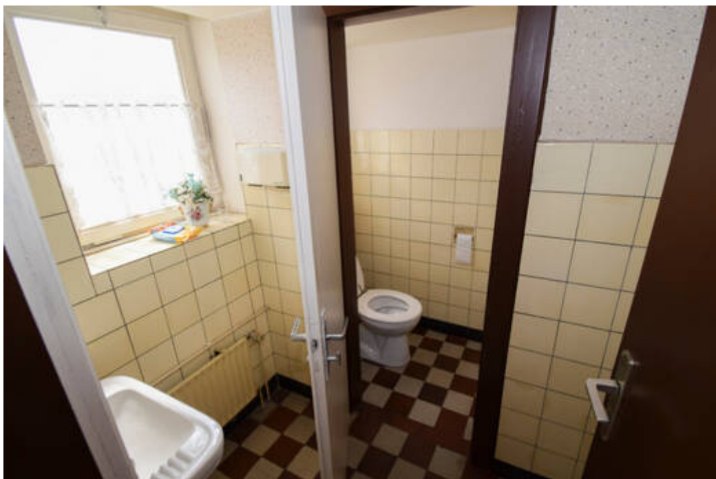
Sanitäre Anlage im EG
