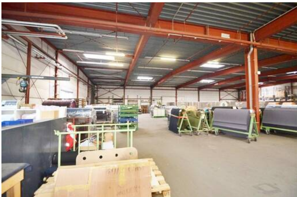
Offene Halle mit Stahlträgersystem
