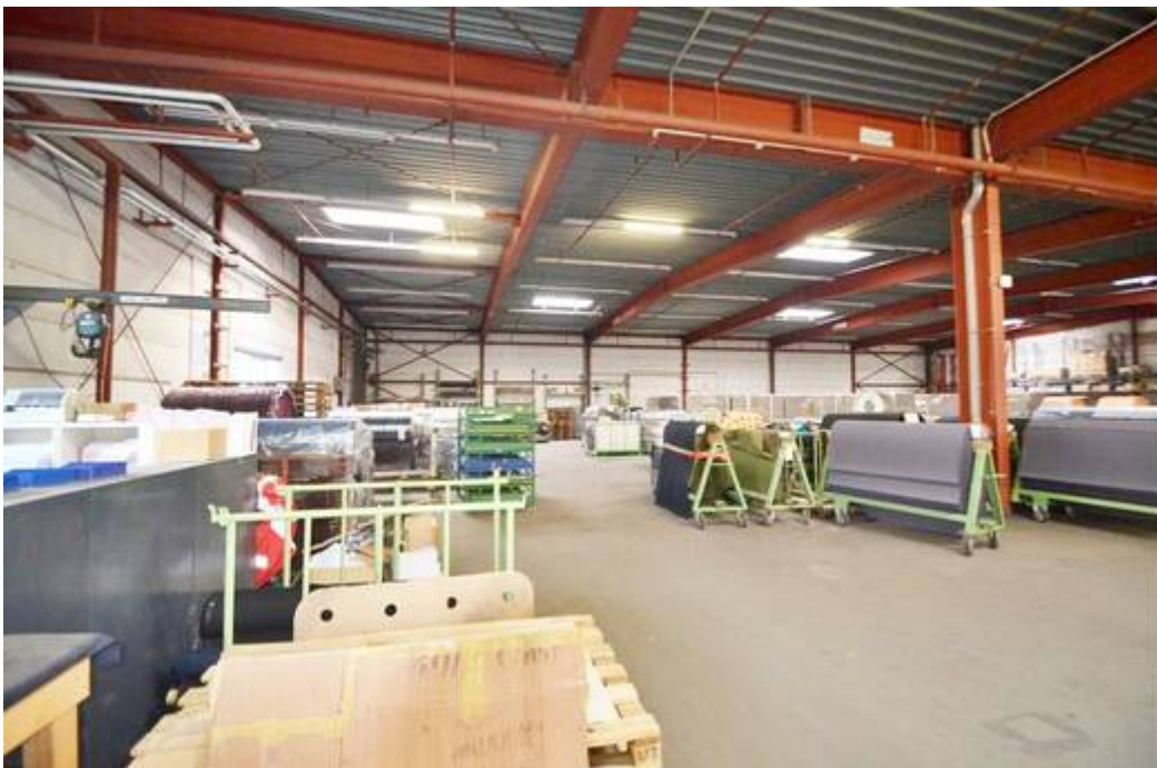
Offene Halle mit Stahlträgersystem
