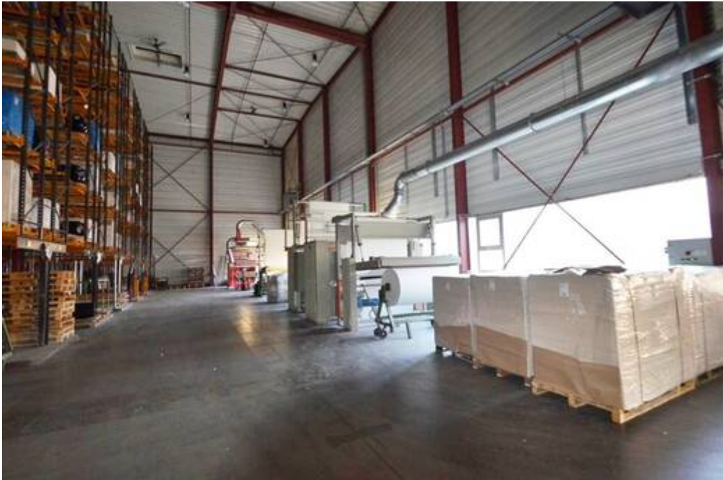
Industriehallen mit Hochregallager
