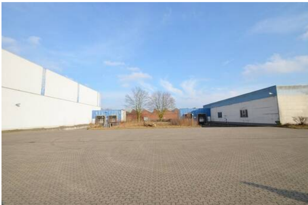
Zwei Industriehallen mit Verladebrücken
