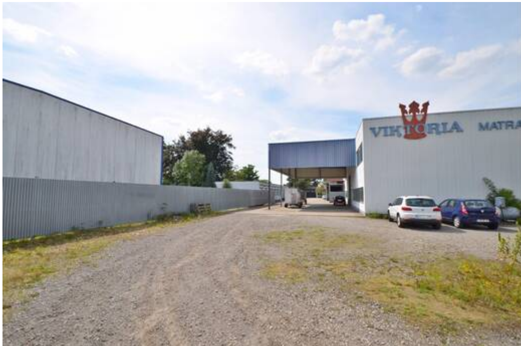
Freifläche für Erweiterung der Hallen
